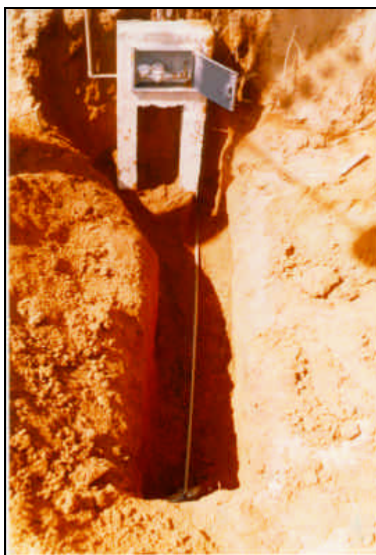
Foto 8 - Instalação de Ramal Predial em PVC com Micromedidor (Hidrômetro)
