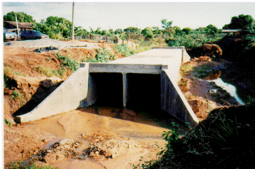
Foto 34 - Galeria de Concreto Armado
